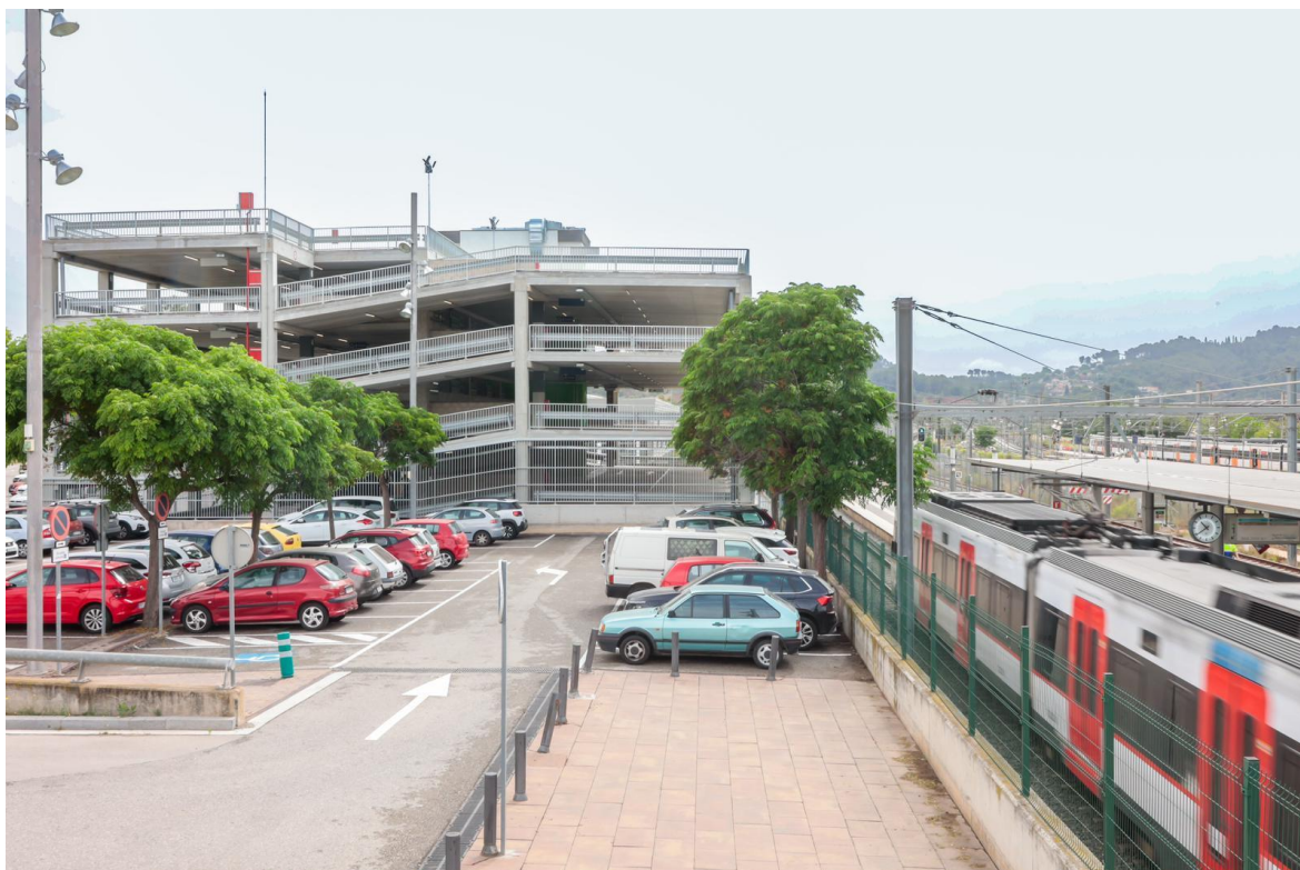
Imatge del nou aparcament d'enllaç de l'estació de Martorell Central d'FGC.
