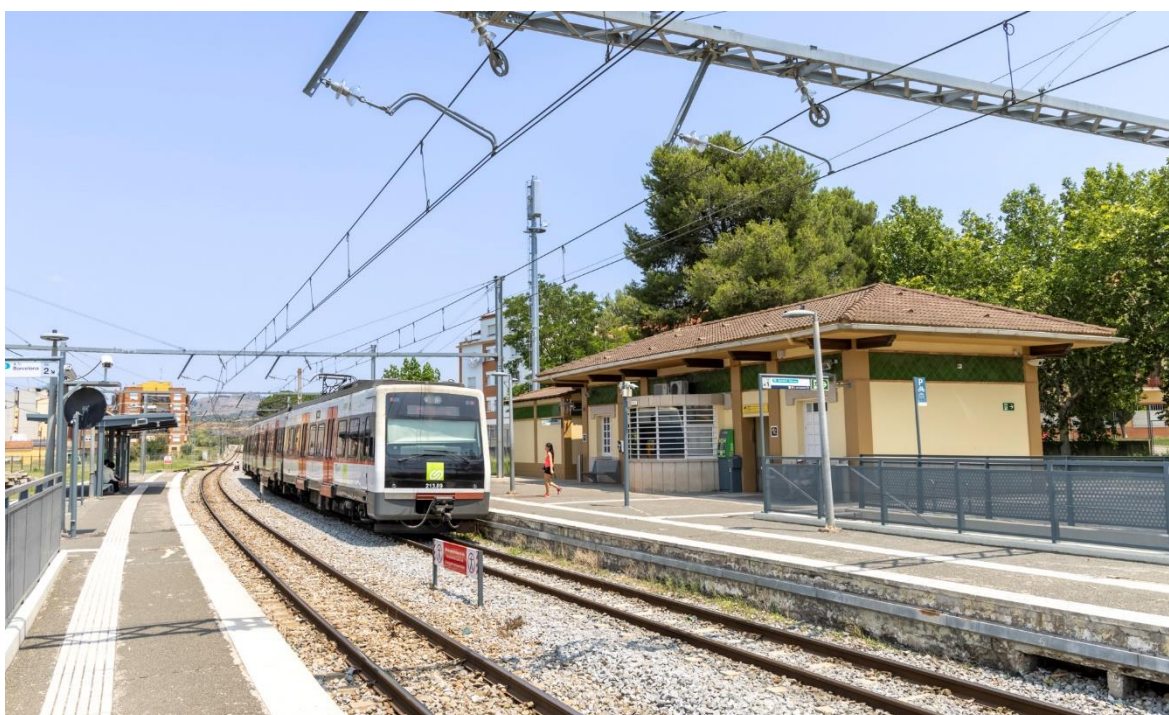
Imatge actual de l'estació de Sant Vicenç | Castellgalí.
