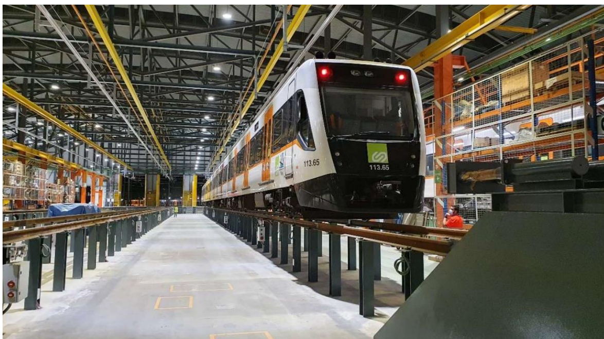
Noves vies 9-11-13 de fossat a l'interior del taller de Rubí.
